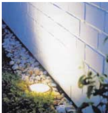
Dekorative Lichtakzente setzen Scheinwerfer für das Erdreich.
