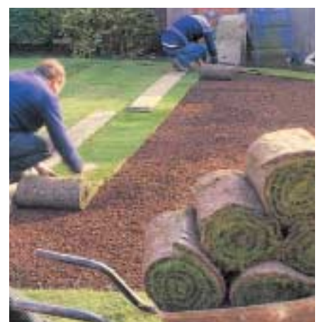
Rollrasen wird in Bahnen verlegt
